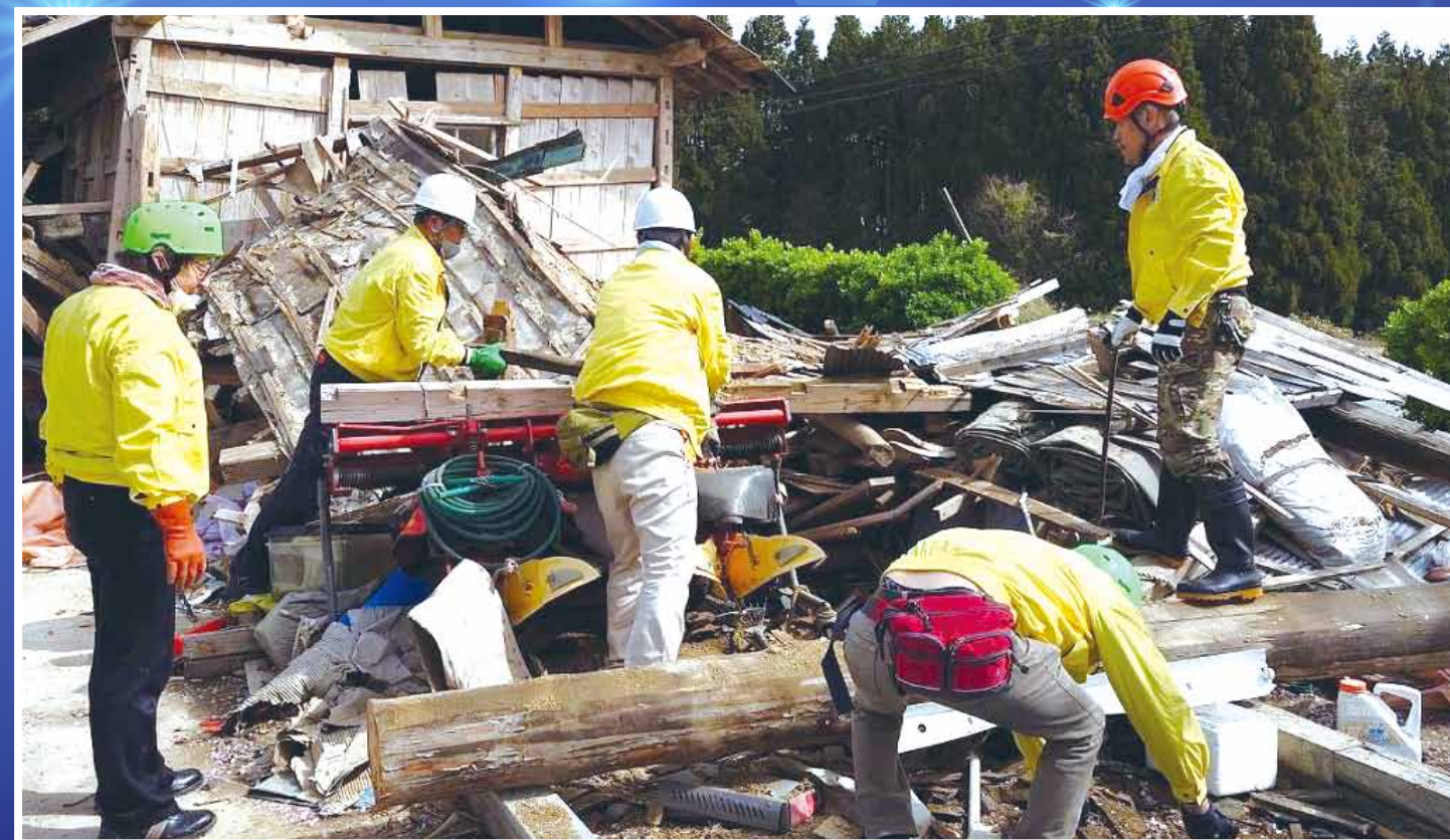
被災し倒壊した家屋のがれき搬出に汗をかいて作業を進めるメンバー
